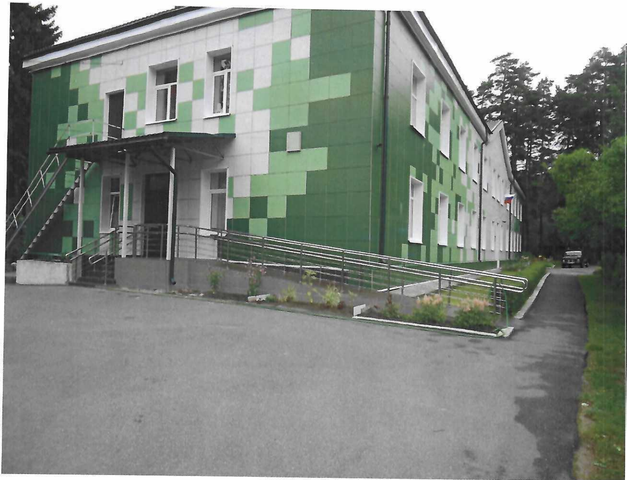
Вход в здание корпуса № 4
